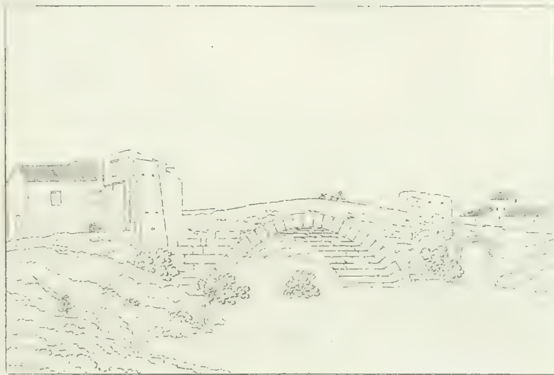
Ponte di Hannover
